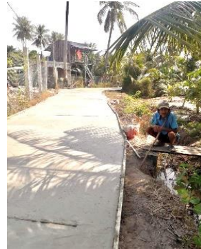
Die befestigte Zugangsstrasse – mit unserem Mitarbeiter Anh Phan
